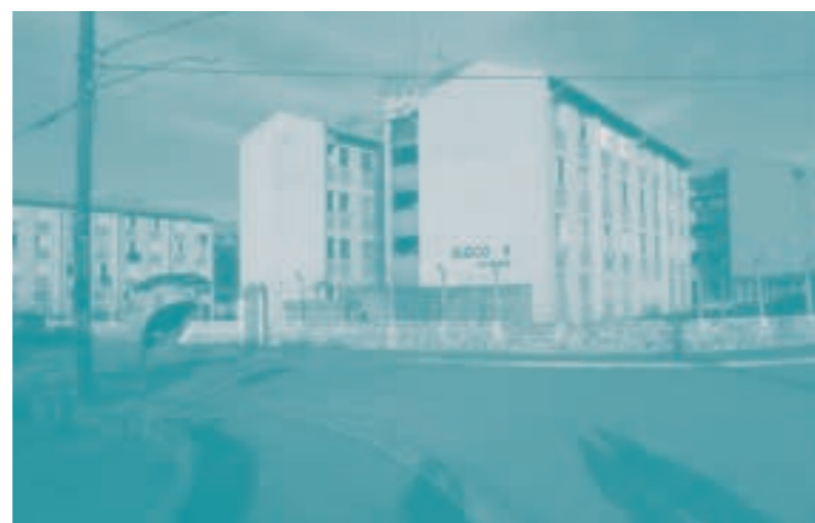
Conjunto Habitacional no bairro do Guapiranga
