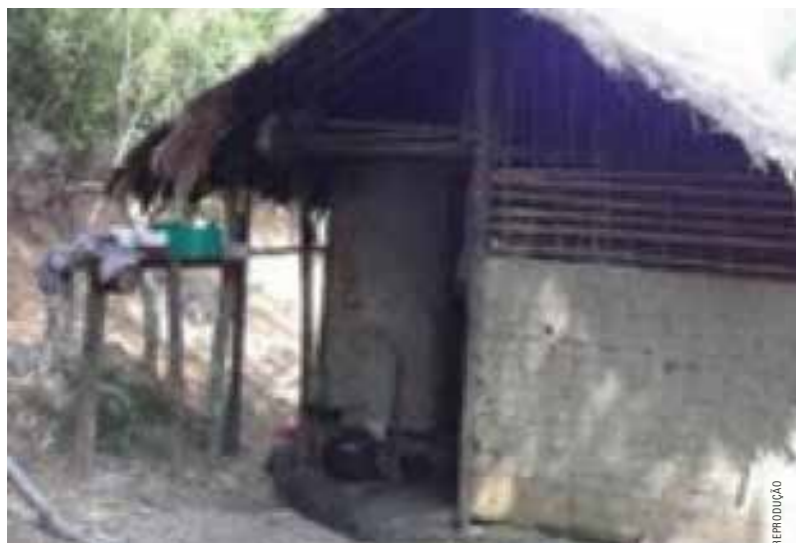
FIGURA 5 Ilhabela – Moradias precárias na Ilha Vitória, 2012. Fonte: PLHIS, 2012.
