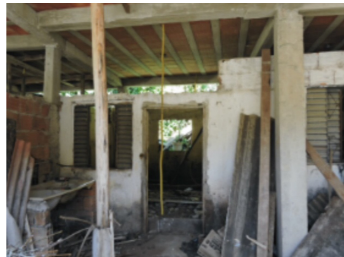
Figura 31. Laje construída na casa em obras.
