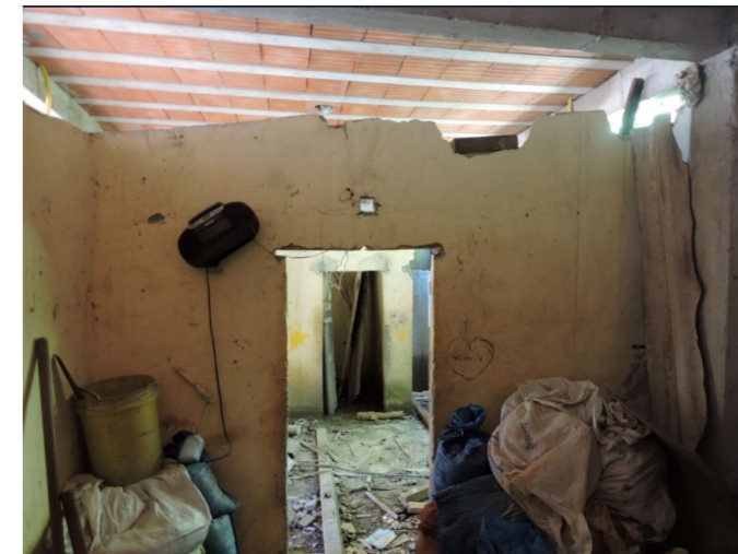
Figura 32. Casa da Morena em obras.
