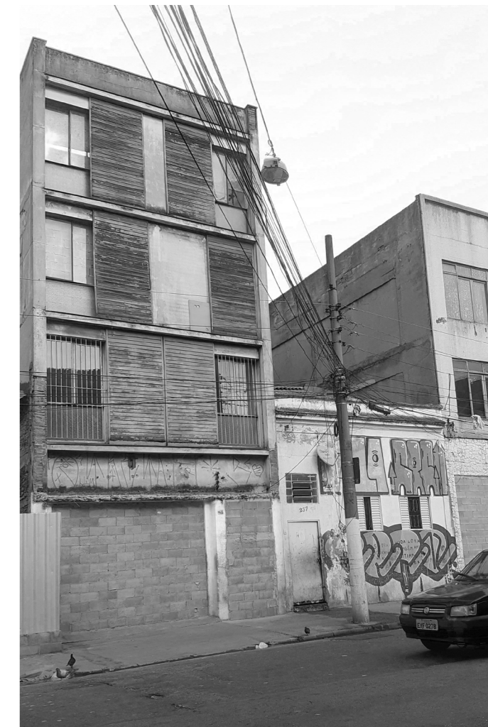
Figura 55. Edifícios emparedados após a remoção das famílias da quadra 36.
