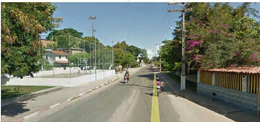
Foto 5 Trecho Urbano da BA-532 (Mar Grande)
