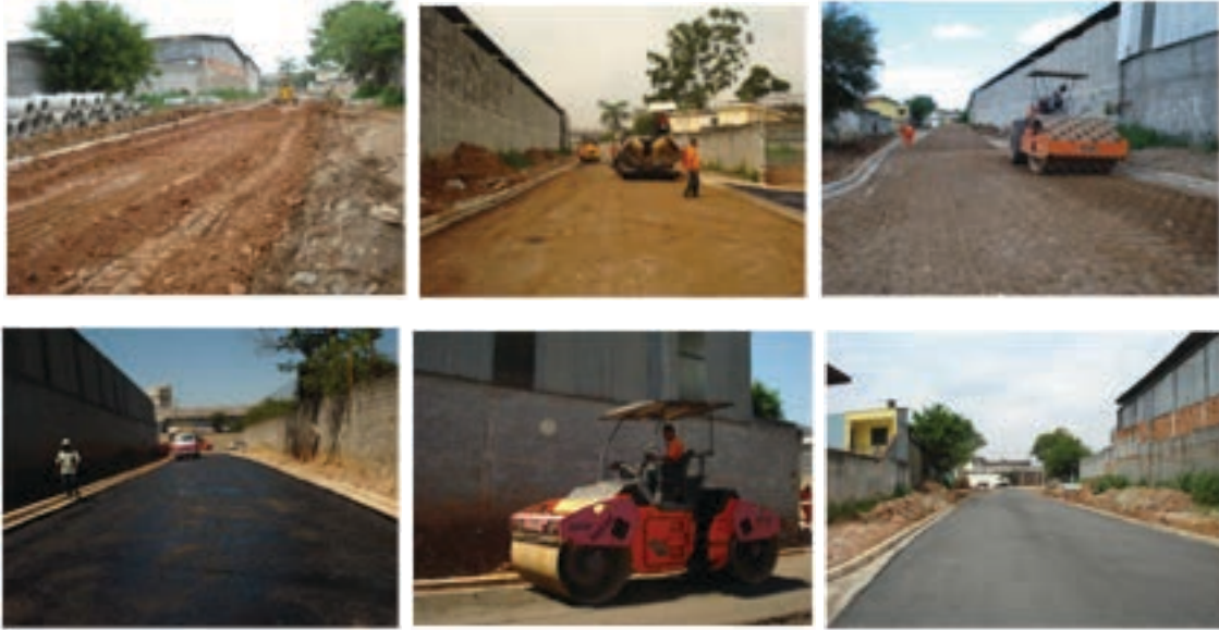
Figura 94 – Uso de Agregados reciclados em sub base de pavimentos e de RAP Espumado (base betuminosa com espuma de asfalto) em São Paulo
