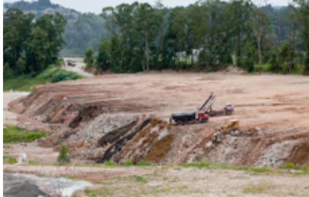
Figura 147 – Aterros de RCC (NBR 15113/2004)
