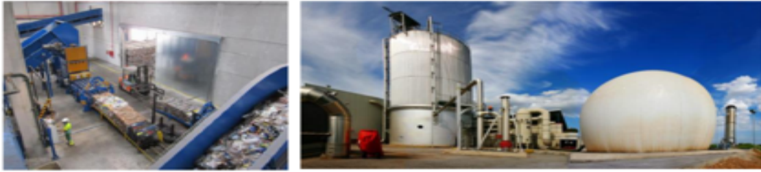
Figura 18 – Tratamento Mecânico Biológico de indiferenciados - segregação das embalagens e biodigestão seca dos orgânicos
