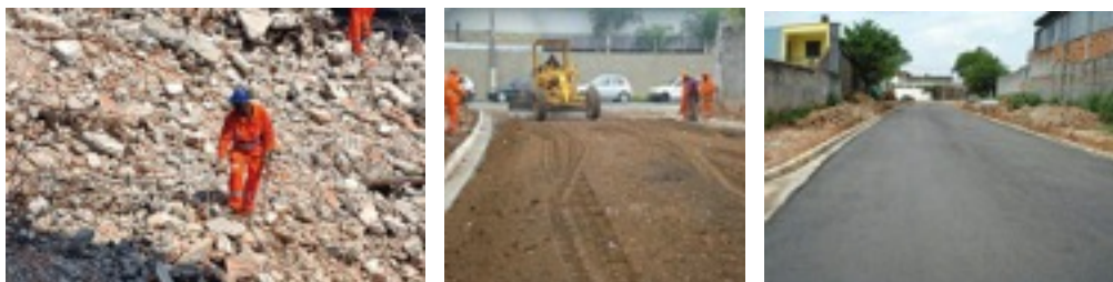
Figura 21 – RCC de demolições utilizado na execução de pavimentos
