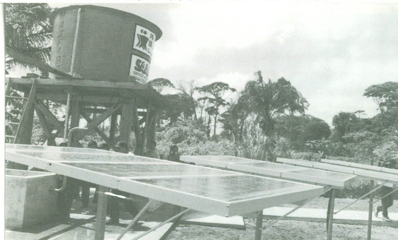
foto 20: Abastecimento de água com poço profundo e sistema fotovoltaico, Cotijuba
