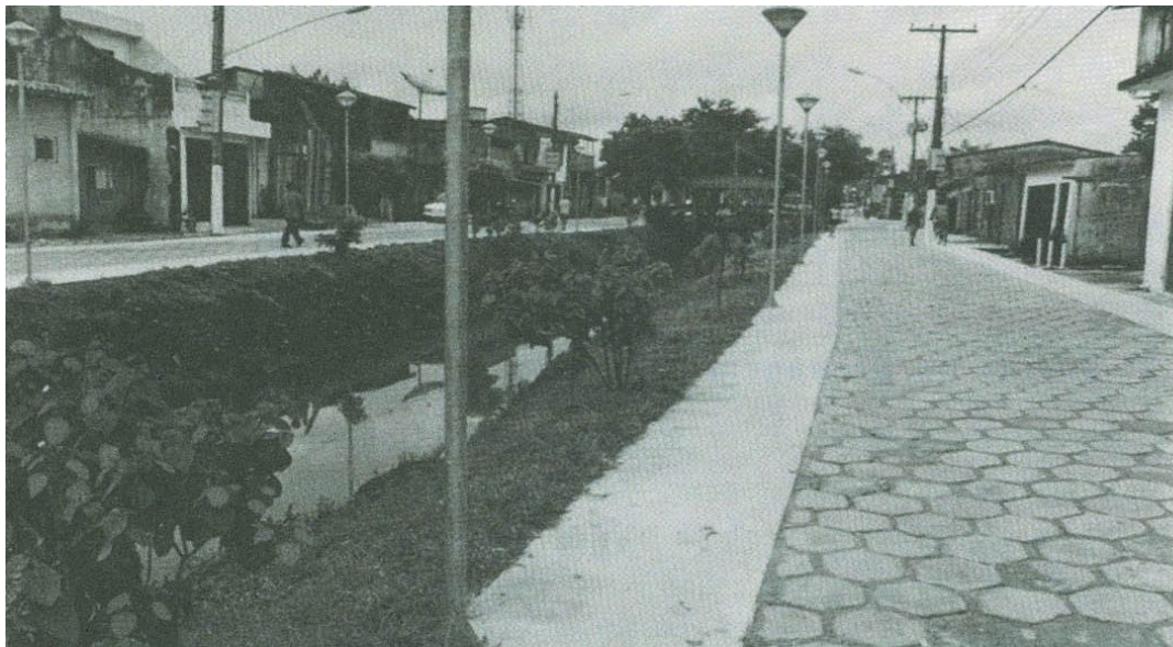
foto 7: Canal da Rua 14 de Março
