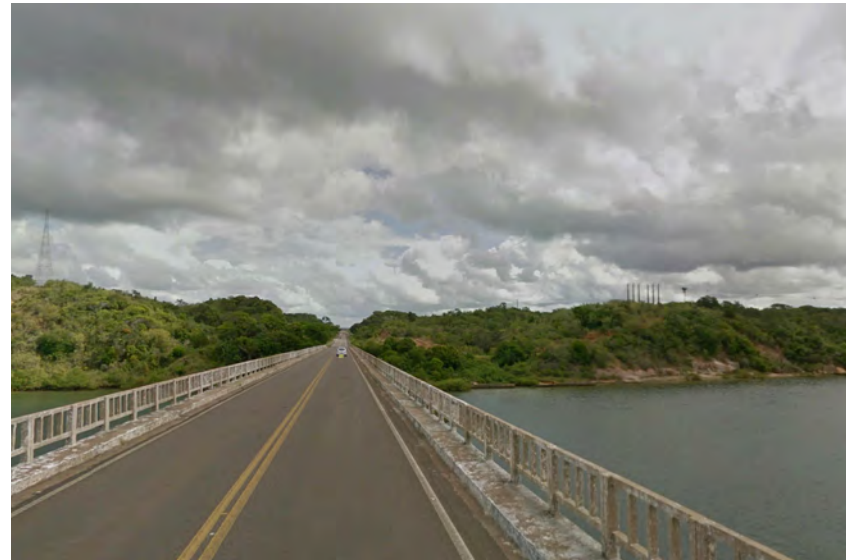
Foto 1 Ponte do Funil sem acostamento
