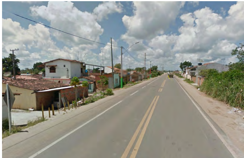
Foto 22 Ocupações à margem da rodovia.
