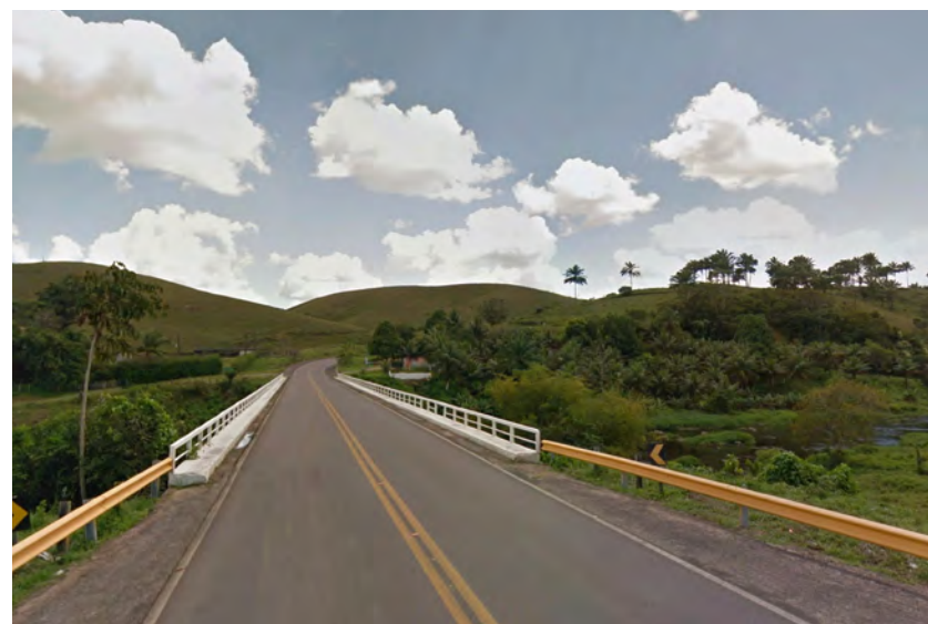
Foto 14 Ponte para pedestres ao lado da ponte para veículos (Onha).
