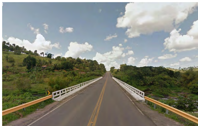
Foto 6 Ponte sem acostamento
