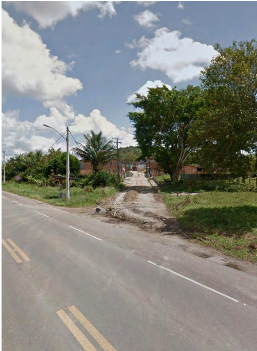
Foto 15 Acesso sem pavimentação às ocupações lindeiras, sem sinalização e sem abrigo de ônibus.
